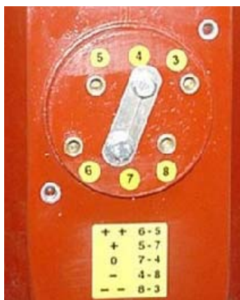
Рис. 19. Регулировочный терминал коэффициента трансформации
