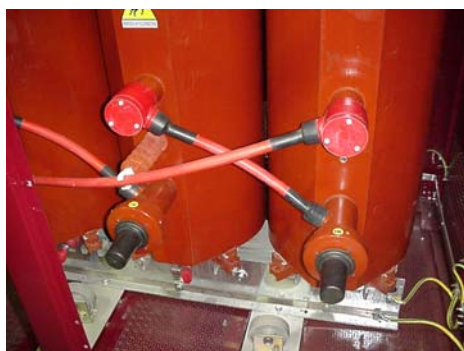
Рис. 5. Проходные изоляторы для высоковольтных вводов
