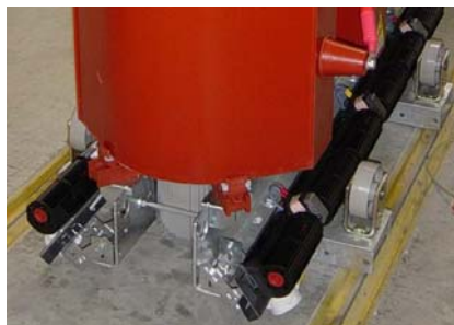
Тангенциальные вентиляторы принудительного обдува повышает нагрузку до 140% номинальной нагрузки
