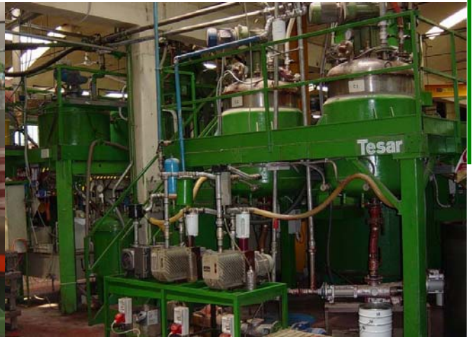
Заливка обмоток эпоксидным компаундом
